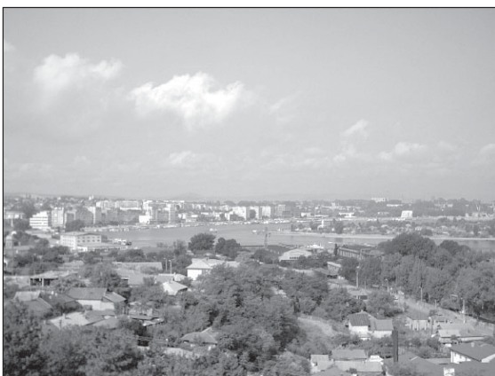
Foto 7. Zona portuară/ The haven area
